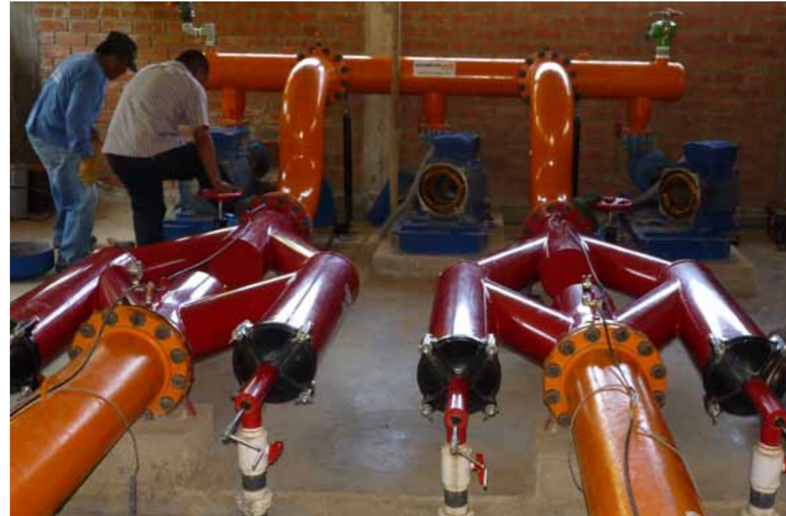
AGROBANCO aportó S/. 1 millón para construir el sistema de riego tecnificado de la APPBOSA, en Sullana (Piura). | AGRUBANKUM qurqa huk waranqa kuti waranqa sulista, sistema rigu tiknifikadu APPBOSA ruwanapaq Sullana llaqtapi (Piurapi).
