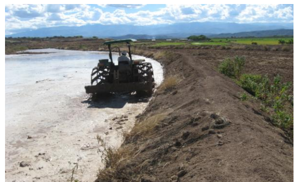
Fig. 5 Altura de bordo adecuado de acuerdo a tamaño de poza
